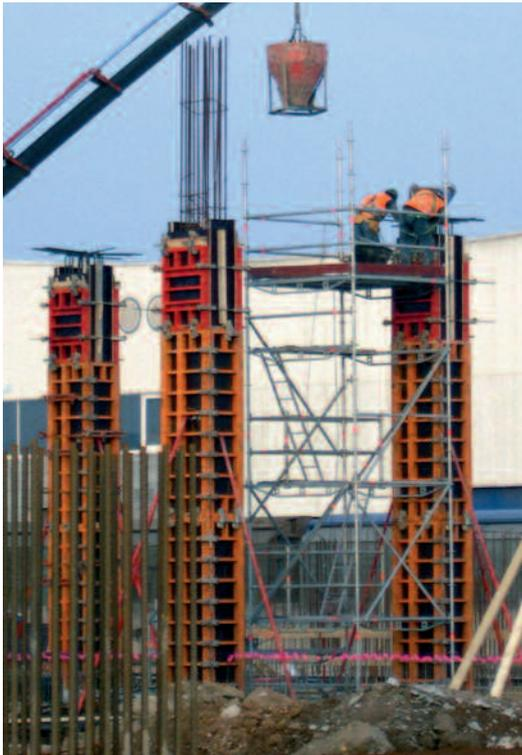
◀ La utilización del material de acero Allround de Layher le permite conseguir la configuración idónea para una torre de trabajo o estructura apropiada para ferrallar muros y realizar el encofrado de pilares. Con el uso de verticales modelo 2.604.xxx, el traslado de la torre puede realizarse mediante grúa, de esta forma se realiza un único montaje.
